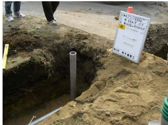
写真-5.5 締固め後の路床と取水管の設置状況
