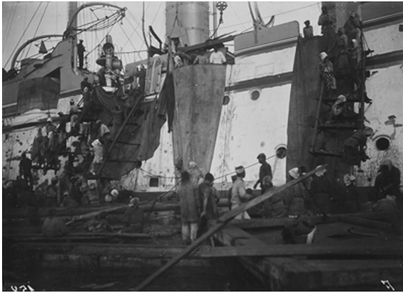
写真4 長崎港石炭積み込み(同上)
