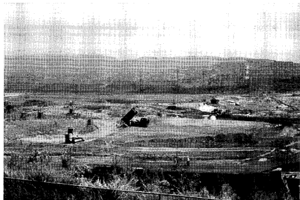
(a) 埋め立て状況
