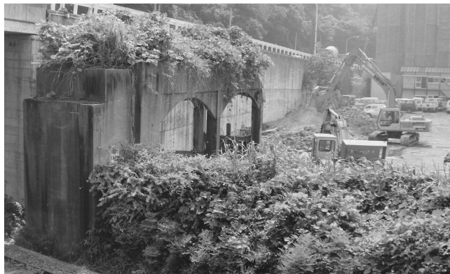
図10 解体が進む鉄筋コンクリート製連続アーチ型ラーメン高架橋（1990.7.18）
