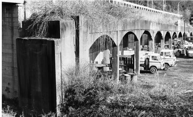
図9 残っていた鉄筋コンクリート製連続アーチ型ラーメン高架橋（1990.1.20）
