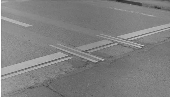
図 12 水門橋両端中央に残るレールと軌道跡の痕跡 (1993.12.23)
