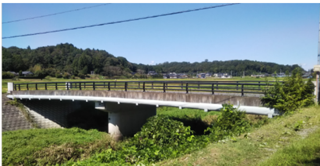
写真 4.1 茨城県管轄 引田橋梁 全景
