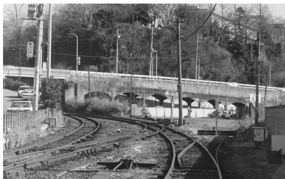
図1 旧茨城交通水浜線の鉄筋コンクリート製ラーメン橋(1990.1.30)
