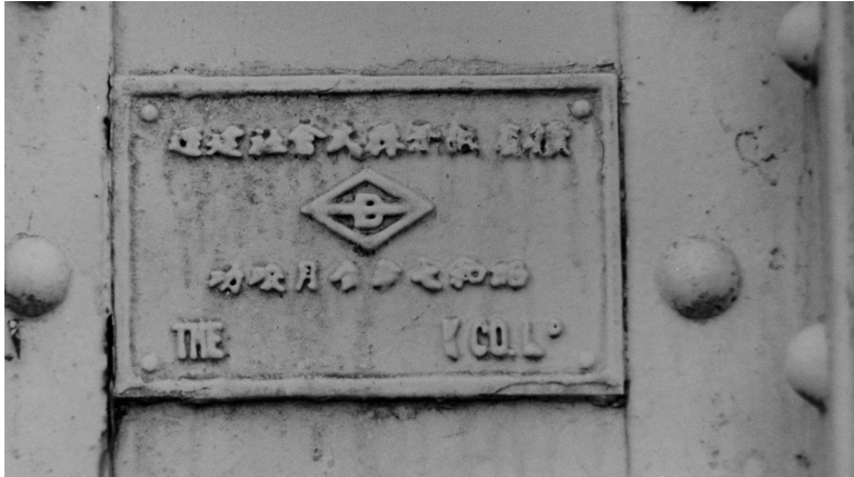
図20 水府橋の建造銘板「横浜船渠株式会社建造 昭和七年参月竣功」(1994.2.7)
