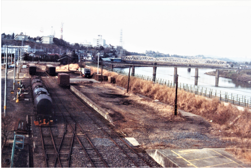
図4 那珂川貨物駅、後方に水郡線那珂川橋梁と水府橋（近藤明德氏；撮影時期不明）
