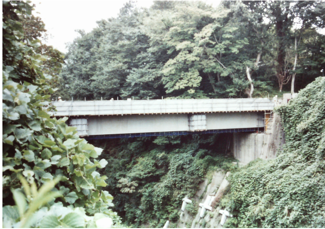
図 16 完成間近の本城橋 (2002.9.22)
