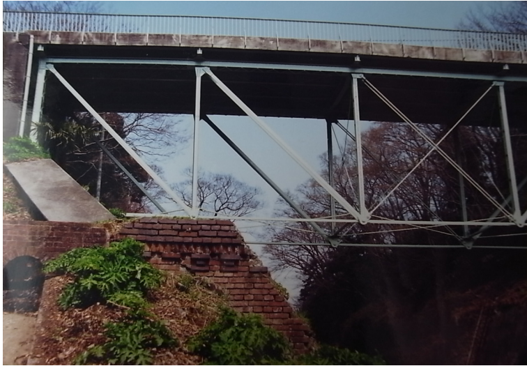
図8 那珂川トンネルの煉瓦造坑門上部と本城橋（1993.4.6）
