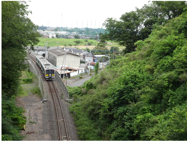
図2 本城橋から見た水郡線付替え高架線路（左側が旧線路）と那珂川貨物線跡（2021.6.25）
