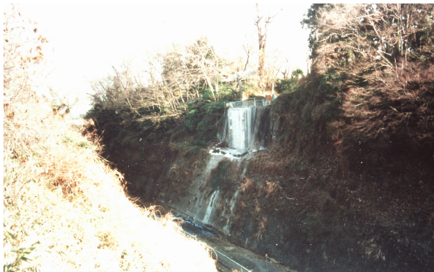
図15 旧橋撤去後の水戸一高側橋台（2002.1.14）
