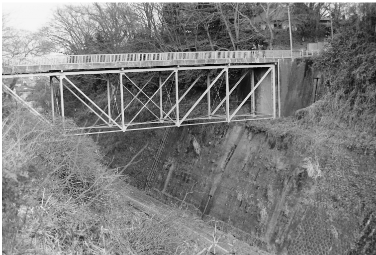
図9 旧那珂川トンネル撤去後のコンクリート工法による擁護壁（1994.2.7）
