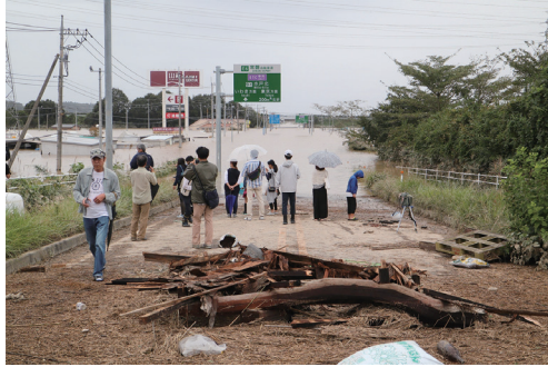
図1 台風19号で被災した水戸北スマートインター周辺 (2019年10月)
