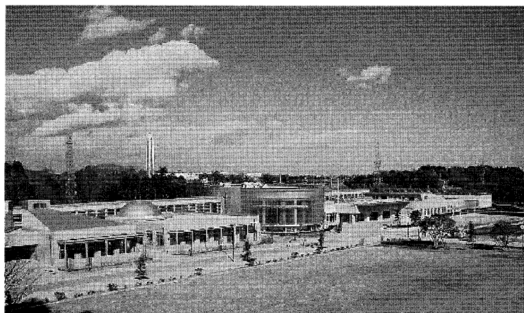
東海村総合福祉センターは、82,700平方メートルの敷地に6,500平方メートルの延べ床面積で、地域福祉センター、高齢者センター、障害者センター、児童センター、保健センターが一体となった施設だ。
